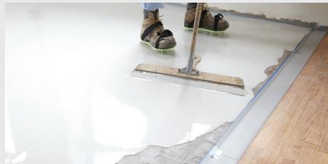
Schönox AP es un compuesto autonivelante con base de yeso sintético para alisar y nivelar los sustratos bajo coberturas flexibles y pisos de madera con espesores de las capas de, al menos, 1/8". Schönox AP, que fue diseñado para interiores, es apto para:
