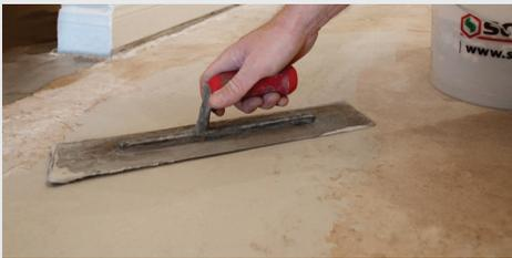
Schönox AST es un compuesto con base de yeso sintético de secado rápido que se utiliza para proporcionar un acabado nivelado muy suave en varios sustratos interiores. Es apto para:
